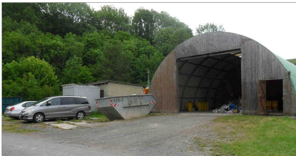
Foto 9: Sortierhalle auf dem Gelände des Zweckverbandes Restabfallbehandlung Ostthüringen in Großlöbichau
