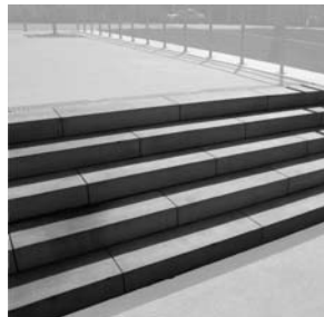
TREPPE Blockstufen, Beton, Mikrofase
