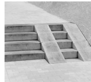
TREPPE Blockstufen, Rampe, Beton
