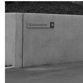
MAUER Fertigteil aus Sichtbeton, konstruktive Fuge
