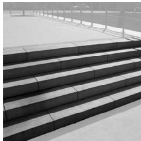
TREPPE Blockstufen, Beton, Mikrofase
