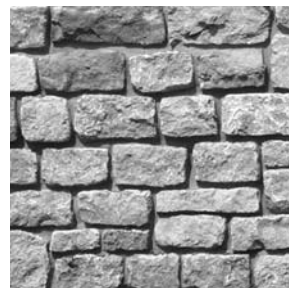
MAUER Naturstein, zurückgesetzte Fuge
