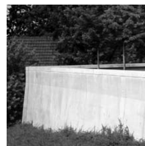
MAUER Ortbeton, konstruktive Fuge
