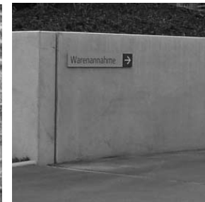
MAUER Fertigteil aus Sichtbeton, konstruktive Fase
