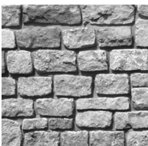
MAUER Naturstein, zurückgesetzte Fuge
