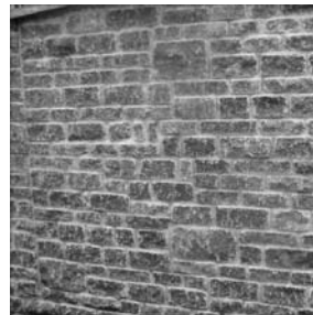
MAUER verblendet mit Naturstein (hammerrecht)
