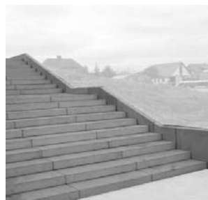
TREPPE Blockstufen, Treppenwange, Beton
