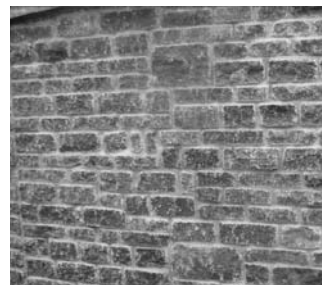
MAUER verblendet mit Naturstein (hammerrecht)
