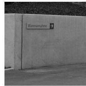
MAUER Fertigteil aus Sichtbeton, konstruktive Fase
