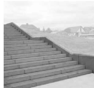
TREPPE Blockstufen, Treppenwange, Beton
