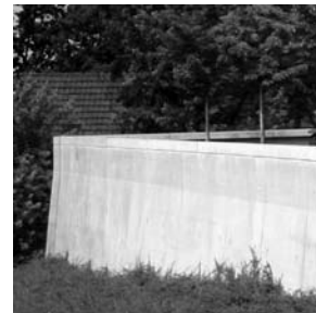
MAUER Ortbeton, konstruktive Fase
