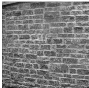
MAUER verblendet mit Naturstein (hammerrecht)
