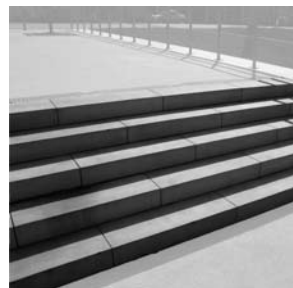
TREPPE Blockstufen, Beton, Mikrofase
