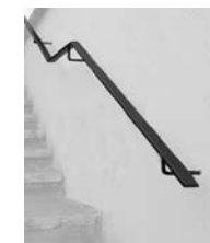
HANDLAUF Wandmontage, Flachstahl (Rundstahl möglich)
