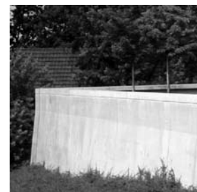
MAUER Ortbeton, konstruktive Fasse
