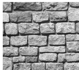
MAUER Naturstein, zurückgesetzte Fuge
