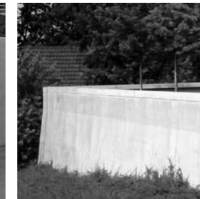
MAUER Ortbeton, konstruktive Fase
