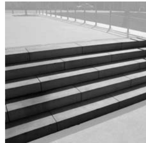
TREPPE Blockstufen, Beton, Mikrofase
