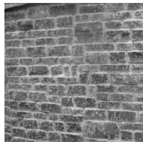
MAUER verblendet mit Naturstein (hammerrecht)
