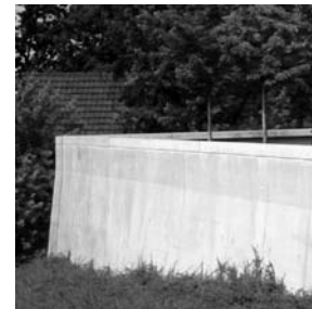
MAUER Ortbeton, konstruktive Fase
