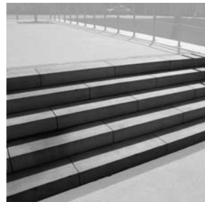
TREPPE Blockstufen, Beton, Mikrofase
