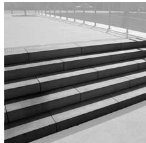
TREPPE Blockstufen, Beton, Mikrofaser
