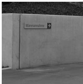
MAUER Fertigteil aus Sichtbeton, konstruktive Fuge
