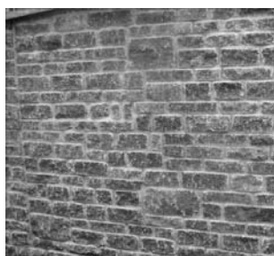
MAUER verblendet mit Naturstein (hammerrecht)
