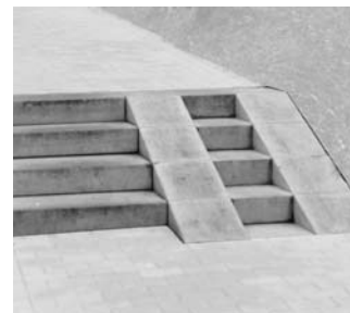
TREPPE Blockstufen, Rampe, Beton
