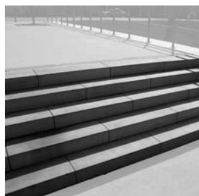
TREPPE Blockstufen, Beton, Mikrofase
