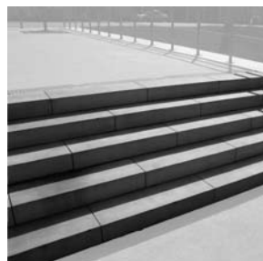
TREPPE Blockstufen, Beton, Mikrofase
