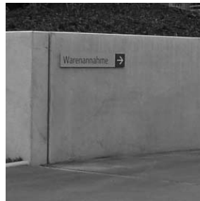
MAUER Fertigteil aus Sichtbeton, konstruktive Fase
