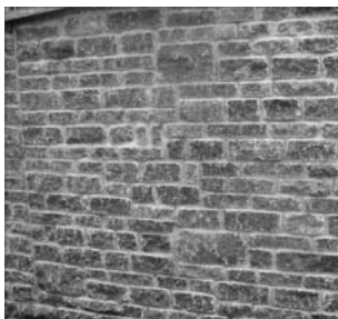
MAUER verblendet mit Naturstein (hammerrecht)
