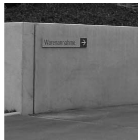
MAUER Fertigteil aus Sichtbeton, konstruktive Fase
