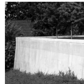
MAUER Ortbeton, konstruktive Fase
