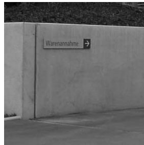
MAUER Fertigteil aus Sichtbeton, konstruktive Fase
