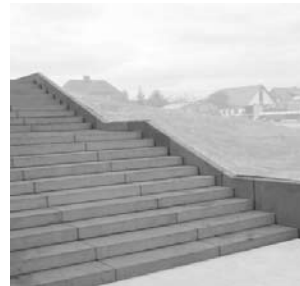
TREPPE Blockstufen, Treppenwange, Beton
