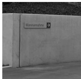
MAUER Fertigteil aus Sichtbeton, konstruktive Fasse
