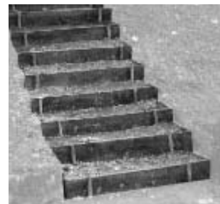
TREPPE Stellstufe (Holz mit Stahlanker) mit Erdrreich hinterfüllt
