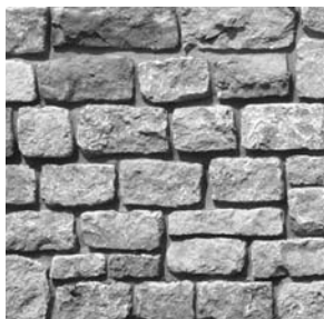
MAUER Naturstein, zurückgesetzte Fuge
