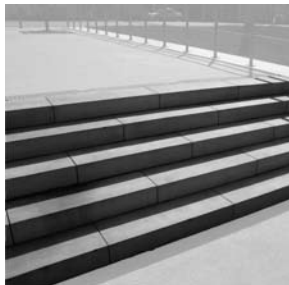
TREPPE Blockstufen, Beton, Mikrofase
