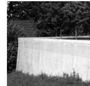
MAUER Ortbeton, konstruktive Fuge
