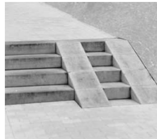
TREPPE Blockstufen, Rampe, Beton
