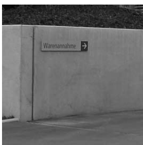
MAUER Fertigteil aus Sichtbeton, konstruktive Fuge
